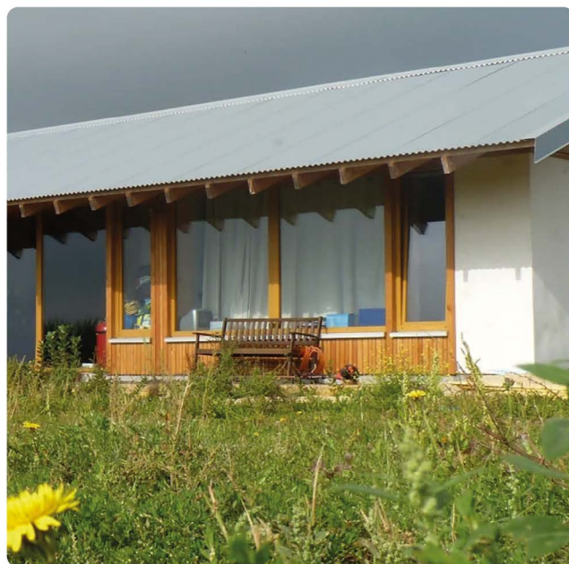
Maison paille porteuse - C.Desmichelle - St-Nom-la-Bretèche (78)
