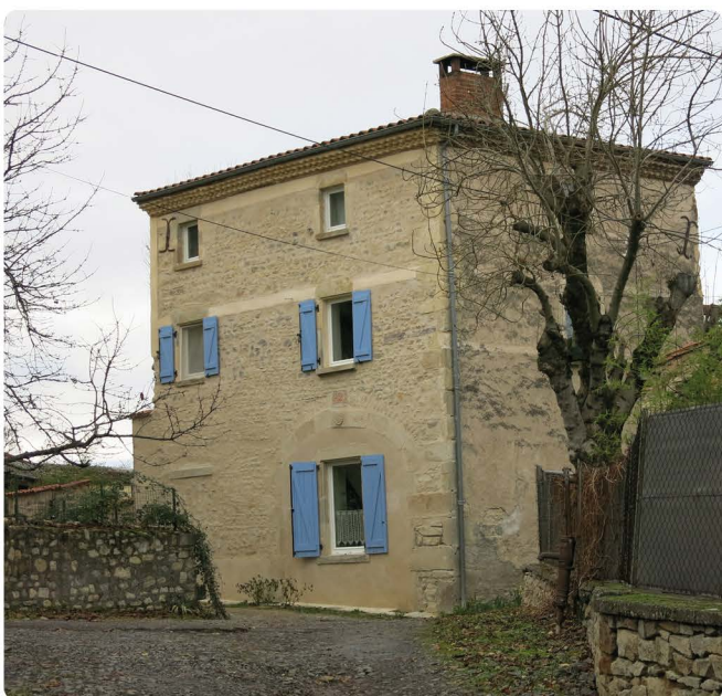
Maison en pierre rénovée (Reignat)
